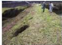
堤体の陥没
