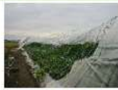
台風によるハウスの倒壊
